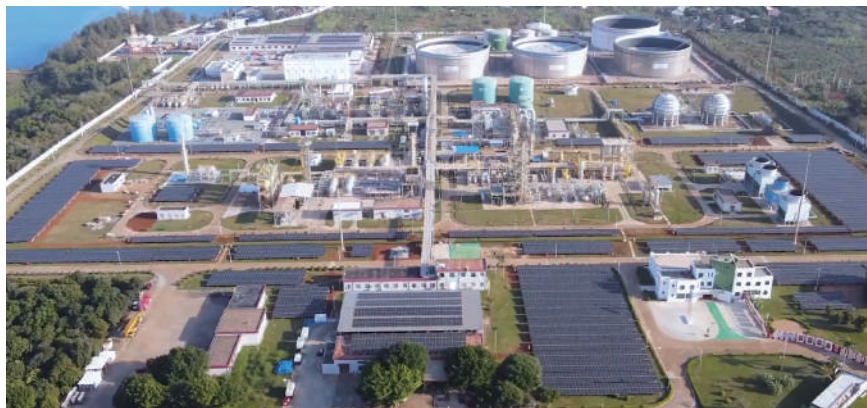
图 30 涠洲岛5MW/10MWh构网型储能项目
